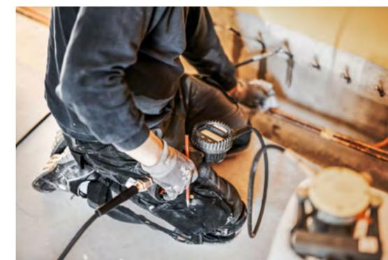
Die Abbildungen zeigen den Ablauf der **Erstellung einer nachträglichen Horizontalsperre** durch einen zertifizierten Fachbetrieb.
