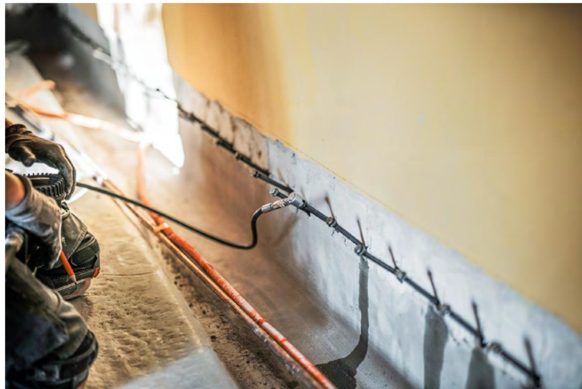
Niederdruckinjektion des Produktes mittels Verpresslanzen.
